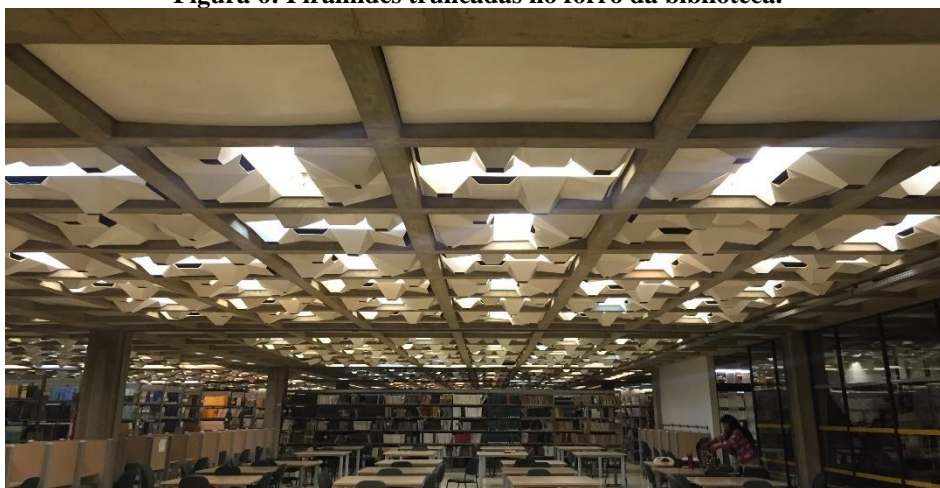
Figura 6: Pirâmides truncadas no forro da biblioteca.
