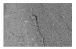
Fig 4. Longitudinal Cracking
